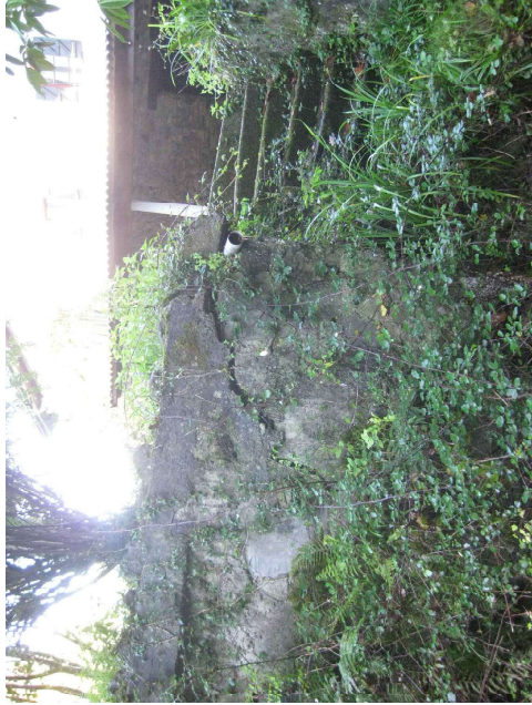
Foto d: Grietas y deformaciones en muro de encauzamiento en margen izquierda junto a caserío Errotaranerdikoa
