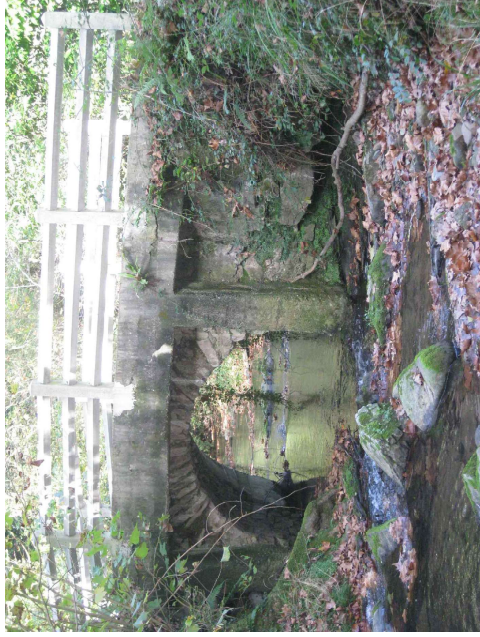
Foto c: Vista del Puente 2. Socavación de estribos
