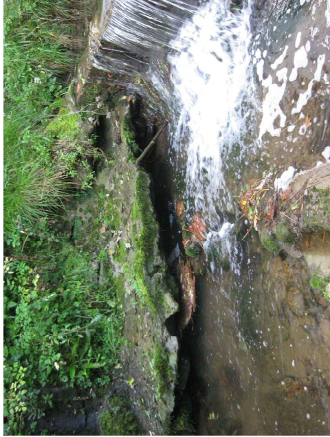
Foto d: Socavación de solera de hormigón junto al azul
